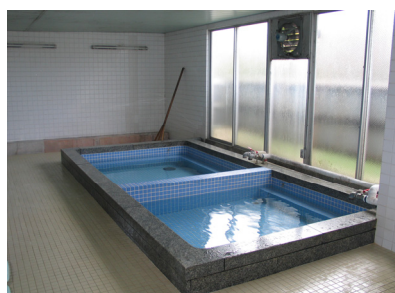
1F 大浴室（浴槽）
